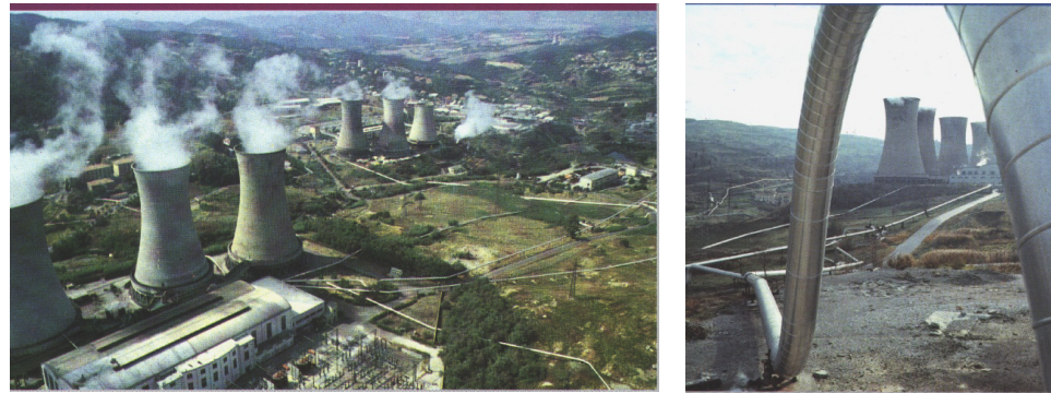
Particolare del vaporedotto di adduzione alla centrale di Larderello e vista aerea della centrale di Larderello
