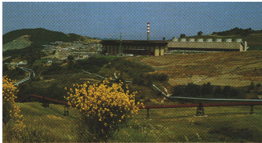
Vista della centrale di Vallesecolo
