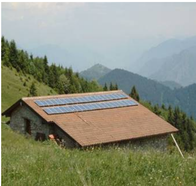
Impianto fotovoltaico stand alone 3 kWp Rifugio Gombo alto (BG)
