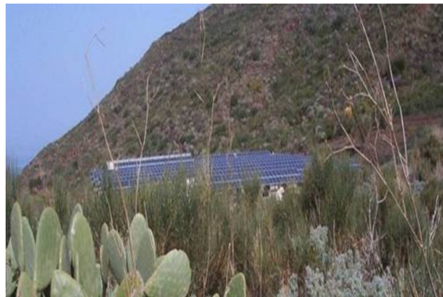
Stromboli: l' impianto per il villaggio di Ginostra Sistema isolato da 100 kWp
